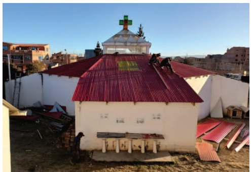
Erneuerung des Daches wird abgeschlossen
